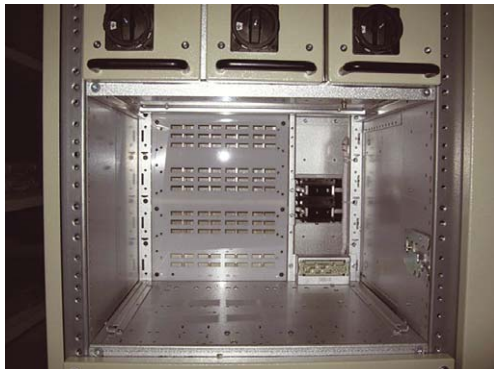
\\ Подключение стандартного выдвижного блока \\
