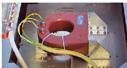
|| Трансформатор тока нулевой последовательности ||
